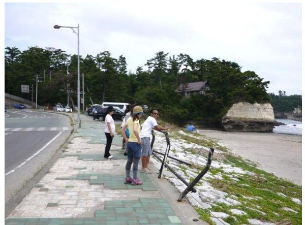
FIGURE 30 剥がれたタイルやへし上がった柵がそのままの七ヶ浜海岸
